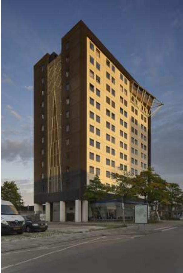
Tasmantoren Assen: Transformatie van kantoor naar 90 appartementen voor jongeren
